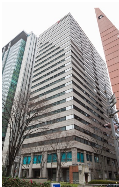
大和ハウス工業株式会社 大阪本社
